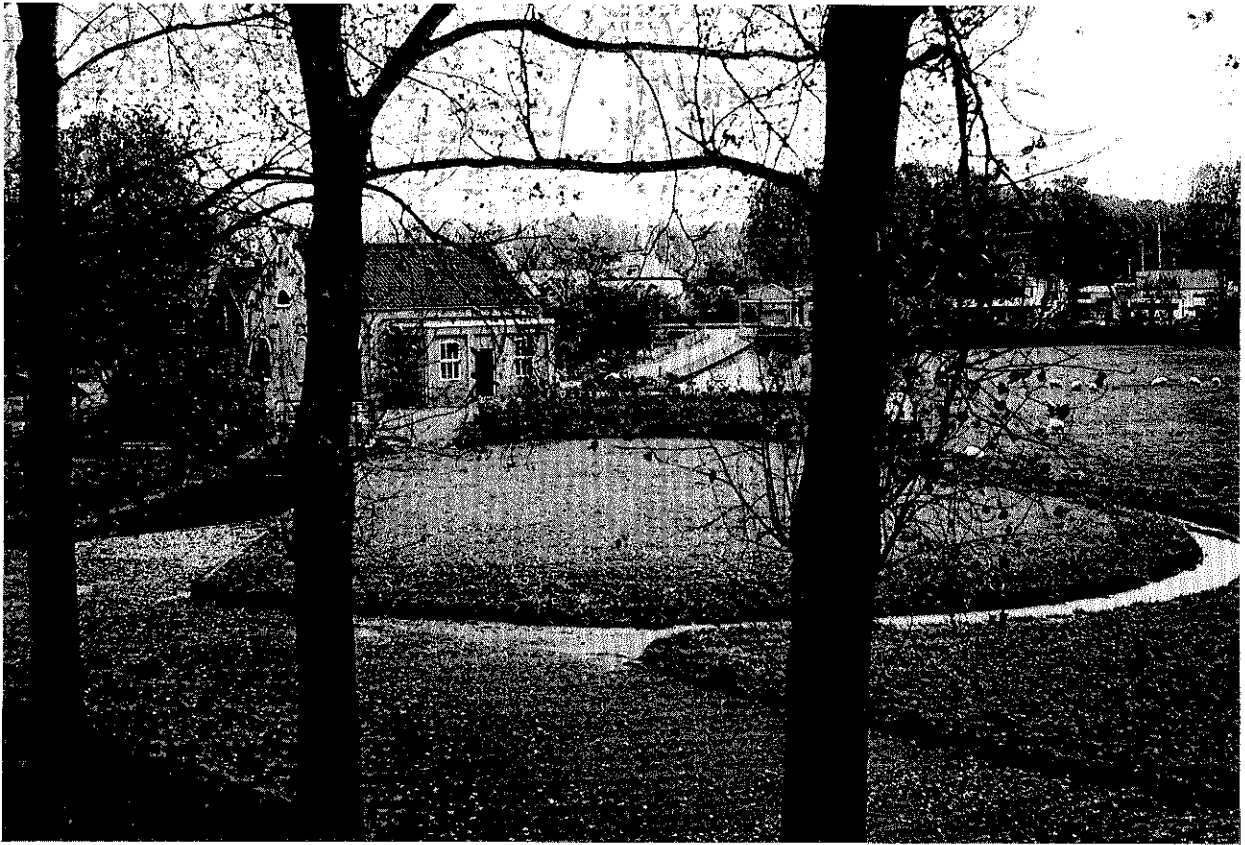
Gemaal van de Aetsvelschepolder, gebouwd als stoomgemaal met scheprad in 1873. Opname 1988.
