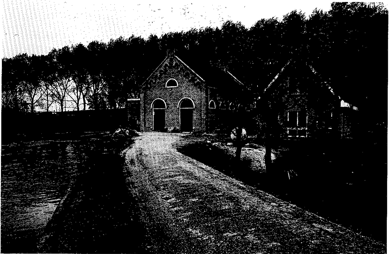
Gemaal van de Aetsvelschepolder. De nieuwe machinistenwoning die in 1988 verrees op de plaats van de oude sluit in hoofdvorm aan bij zijn voorganger.
