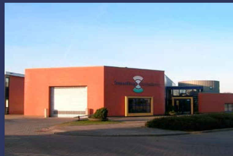
Foto Besseling Installatie
